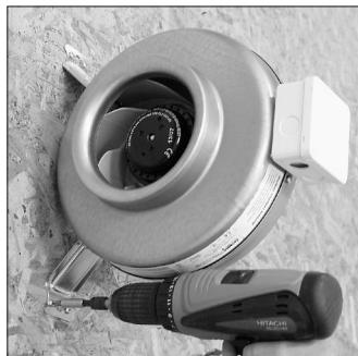
1. Merkitse **A**-mitta seinälle tai kattoon ja kiinnitä puhallin ruuveilla,puhallin ruuveilla.
